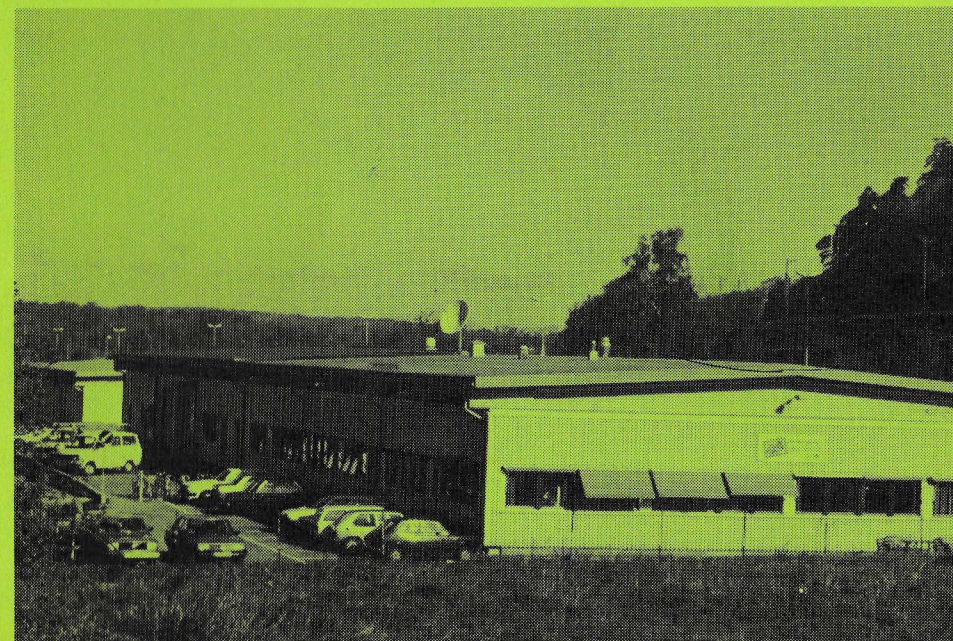
KJELLE MONTØRSTASJON MED PARABOLANTENNEN
